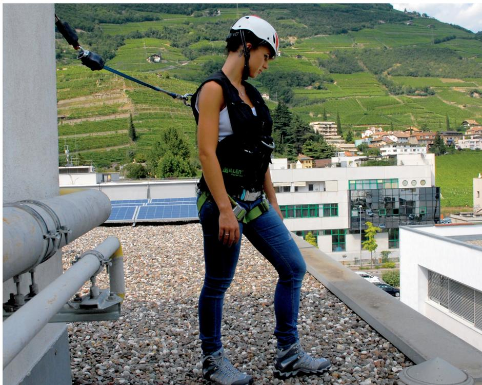
Einsatz eines Höhensicherungsgerätes
