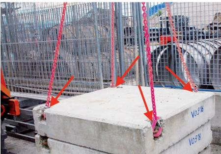
Bringen sie bei der Verwendung von Mehrstrang Anschlagmittel, die Haken immer von Innen nach Außen ein.
