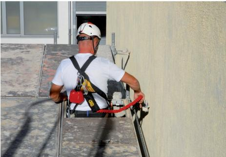
Vor dem Ausstieg sichert sich der Benutzer, bevor er einen Abstand von mehr als 100cm zwischen der Standfläche auf der Zugangsleiter und dem Gerüstboden erreicht. Zur Sicherung werden zwei Systeme mit automatischem Einzug verwendet. Es können auch 2 dem Gerüst angepasste Kurzseile mit Energiebremse oder eine Kombination von beiden Varianten verwendet werden.
