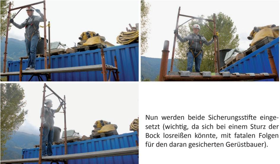
Nun werden beide Sicherungsstifte eingesetzt (wichtig, da sich bei einem Sturz der Bock losreißen könnte, mit fatalen Folgen für den daran gesicherten Gerüstbauer).
