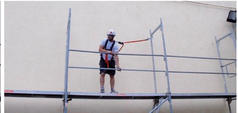
So gesichert werden nun die nächsten Gerüstbocke positioniert, mit den Sicherungsstiften gesichert und das Geländer eingesetzt und geschlossen.
