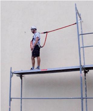
So kann das Gerüst nach und nach sicher und schnell aufgebaut werden, wobei der Sturzfaktor meist unter 0,5 verbleibt. Die Gefahr eines Pendelsturzes bleibt aber bestehen (Feldweiten von 2 bis 3 m).
