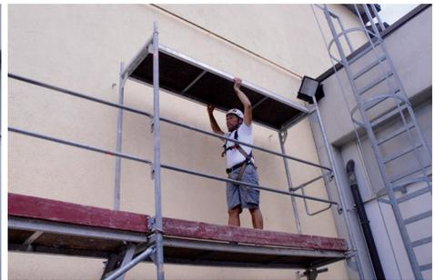
Das nachfolgende Personal könnte nun sogar auf die neue Gerüstebene ohne Sicherung aussteigen, vorausgesetzt, dass es immer hinter dem fertigen Parapet und in sicherer Entfernung zur nächsten Absturzkante bleibt.
