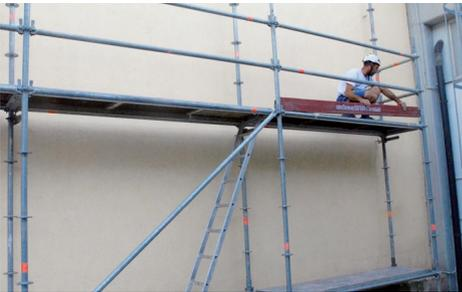
Das nachfolgende Personal könnte nun sogar auf die so zuvor errichtete Gerüstebene ohne weitere Sicherung aussteigen, vorausgesetzt, es sich immer hinter dem fertigen Parapet und in sicherer Entfernung zur nächsten Absturzkante bleibt.
