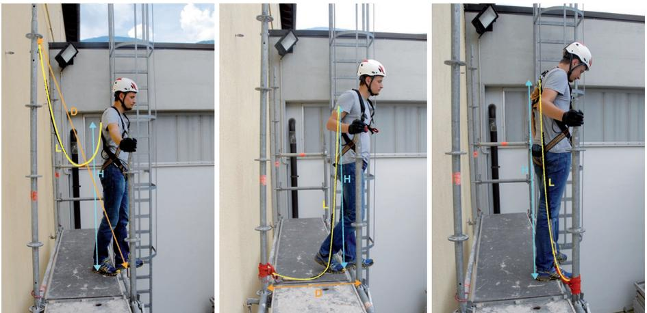
**Beispiel zur Bestimmung der Mindest-Anschlaghöhe eines Verankerungspunktes einer Absturzsicherungsgarnitur am Gerüst:**
