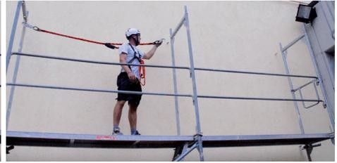
Mittels eines zweiten freien Hakens sichert sich der Gerüstbauer am zuvor gesetzten Gerüstbock, danach kann er den hinteren Haken vom Bock lösen.
