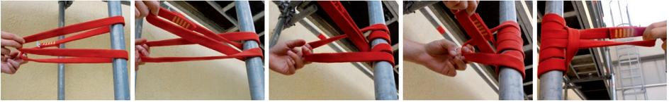
So gesichert steigt der Gerüstbauer die Leiter hinauf und schiebt abschnittsweise den \*PRUSIK weiter, wobei zu beachten ist, dass dieser immer so hoch wie möglich positioniert wird. An der Ebene angekommen, kann er nun einen Gerüstbock positionieren.
