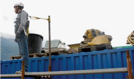
*N.B.: Der Gerüstbauer darf keinem freien Fall ausgesetzt sein!*
