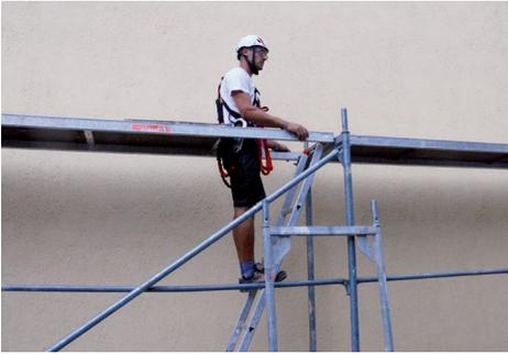
Der Zustieg darf nur so hoch sein, dass der vorlaufende Gerüstboden wie ein 1m Parapet fungiert.
