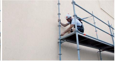
So kann das Gerüst nach und nach sicher und schnell aufgebaut werden, wobei der Sturzfaktor meist unter 0,5 verbleibt, und die Gefahr eines Pendelsturzes zwar möglich bleibt (Feldweiten von 2 bis 3 m), aber unwahrscheinlich ist, da das provisorische Geländer beim späteren richtigen Positionieren immer noch einen leichten Schutz bietet. Sollte doch ein Pendelsturz passieren, so verhindert der bereits richtig eingesetzte untere Längsriegel einen Kontakt mit evtl. „scharfen Kanten“.
