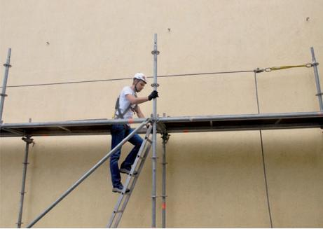
Der Mitarbeiter darf sich nur so hoch auf der Zustiegsleiter befinden, dass der vorlaufende Gerüstboden wie ein 1m Parapet fungiert.
