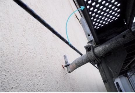
Die Lebenslinie sollte oberhalb der Verankerung verlaufen, so kann die gesicherte Person immer konstant verankert bleiben. Gegebenenfalls die Lebenslinie über der Gerüstbockverankerung anbringen, sollte das Gerüst in der Höhe weitergebaut werden (Achtung, so wird aber die mögliche Seilauslenkung größer)!
