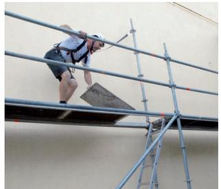
Absturzsicherung mit automatischem Einzug. Die Sicherung soll möglichst hoch angebracht werden, und zwar an der Rundstütze bei der Ausstiegluke an der Fassadenseite.
