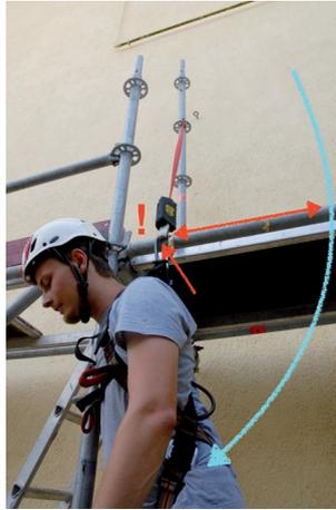
dehnt und durchschneidet. Die Gefahr der Entstehung eines großen Fangstoßes ist gegeben, da die abstürzende Person einer annähernden freien Fallgeschwindigkeit ausgesetzt ist!
