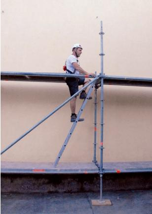
Der weiter ungesicherte Zustieg darf nur so hoch sein, dass der vorlaufende Gerüstboden wie ein 1m Parapet fungiert.
