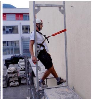
Die weitere Sicherung erfolgt nun z.B. mittels dem „Standard Y - System mit Fallabsorber“ am Gerüstbock.
