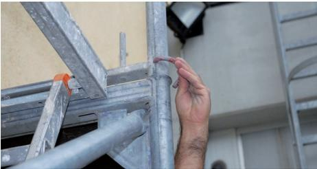
Nun werden beide Sicherungsstifte eingesetzt (wichtig, da bei einem Sturz sich der Bock losreißen könnte, mit fatalen Folgen für den daran gesicherten Gerüstbauer).
