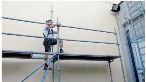
Nun kann der Gerüstbauer, dank des provisorischen Geländers, auf die neue Gerüstebene aussteigen und sichert sich, bevor er sich den Bereichen ohne Geländer nähert, mittels
