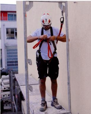
Jetzt kann die Sicherung mittels Bandschlinge entfernt werden.
