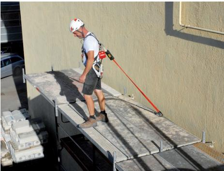
Zuerst muss die Gerüstebene aus Stabilitätsgründen sicher an der Fassade verankert werden; Beachten Sie aber auf jeden Fall auch die diesbezüglichen Hinweise des Herstellers). Jetzt kann er sich (so kurz wie möglich) an der Lebenslinie einhängen (Achtung: bei dieser Sicherungsposition ist der Sturzfaktor nicht ideal, deshalb immer das Verankerungsseil kurz lassen).
