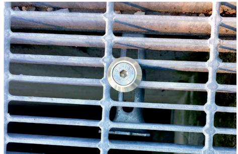
**Lichtschachtgitter müssen die möglichen Belastungen standhalten und dürfen nicht leicht entfernbar sein; dies kann auch mittels spezieller Verankerungen erfolgen.**
