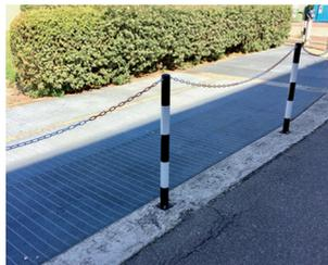
**Nicht ausreichend tragfähige Gitter sollen vor unbefugter Benützung (z.B. durch Pkw's) ausreichend gesichert werden, am besten nicht durch ein Schild, sondern durch Absperrungen.**
