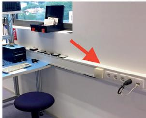
**Mit durchgehenden Installations-schächten und Wandsteckleisten können eventuelle Kabelstol-perfallen am Boden minimiert werden.**
