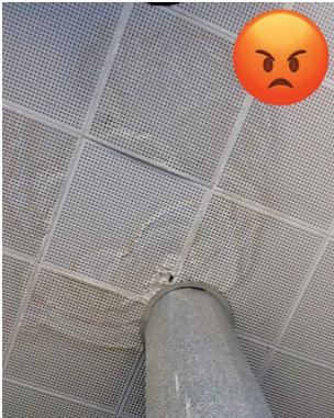
**Beachten Sie Feuchtigkeitseinbrüche am Gebäude, Schimmelbildung (speziell oberhalb von abgehängten Decken) oder instabile Deckenbeläge können die Folge sein.**
