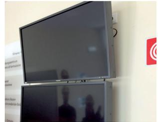
Achten sie bei abgehängten oder wandhängenden Hilfsmitteln immer auf die notwendige Stabilität der Tragfähigkeit der Befestigung und des Untergrundes, speziell bei Gipskarton oder Faserplatten.
