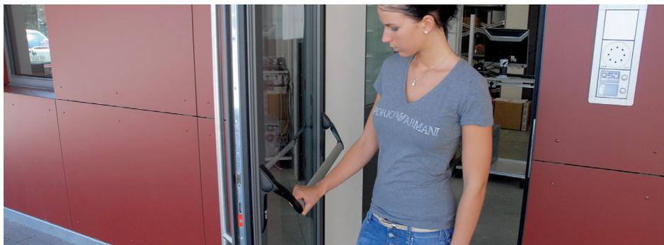
**Panikhebel mit der Norm EN 1125 garantieren eine sichere und schnelle Öffnung der Fluchttüre**
