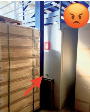
Brandschutzeinrichtungen sollen so positioniert werden, dass sie leicht einsatzfähig und auffindbar sind, also nicht so wie auf dem Bild!
