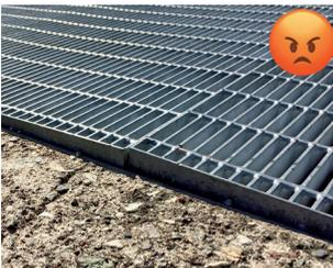
**Aufstehende Gitter können zu gefährlichen Stolperfallen werden, außerdem könnte das Gitter bei dynamischer Belastung verschoben werden und den Schacht freigeben.**
