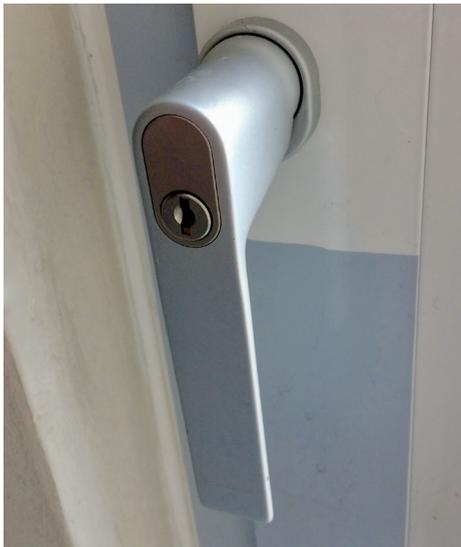
***Verschließbare Fenstertür (besteht beim Öffnen Absturzgefahr, so darf der Schlüssel darf nur geschulten Personal überlassen werden, welches über die notwendige PSA zur Absturzsicherung verfügt)***
