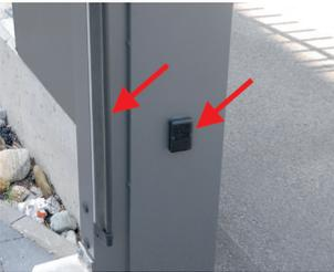
Automatisches Schiebetor mit Lichtsensoren und Druckleiste zur Sicherung gegen Klemmen und Quetschen.
