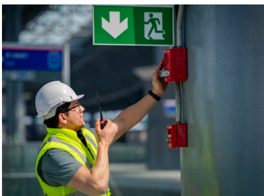
La qualificazione diventa obbligatoria per la manutenzione antincendio © shutterstock
